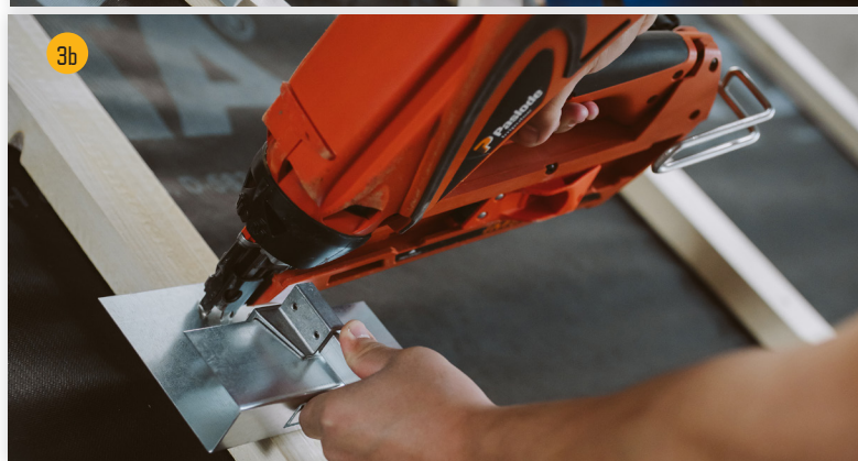
3 3b Dachlattenhalter verschrauben oder nageln
