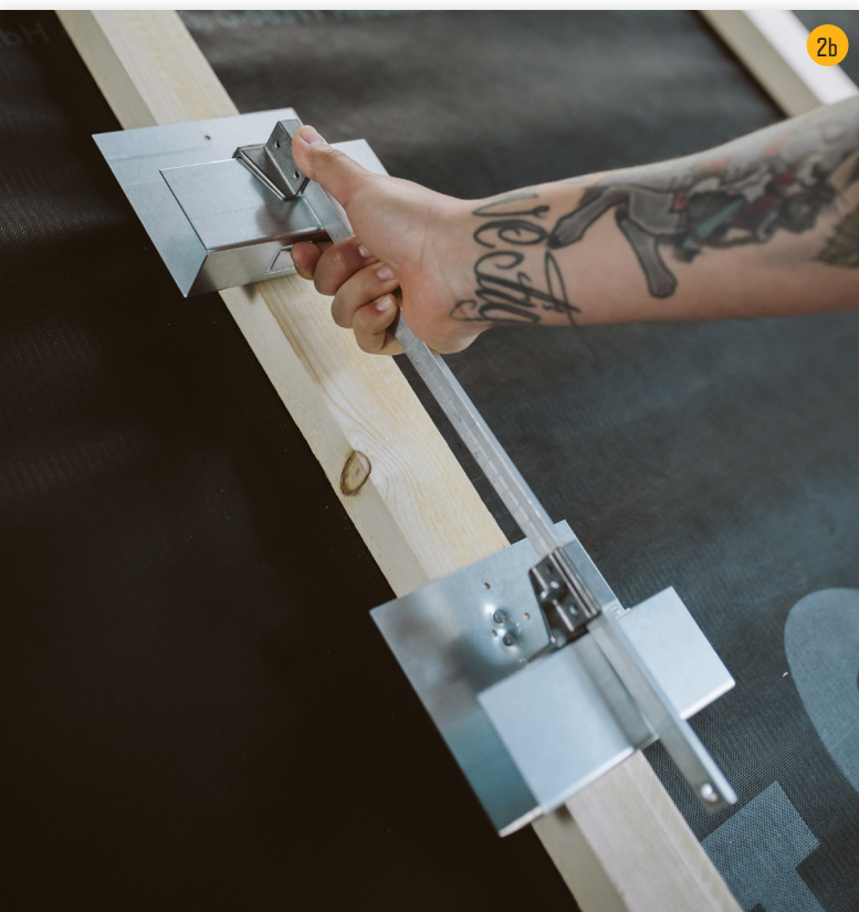
2b .... mittels Lattenknecht positionieren
