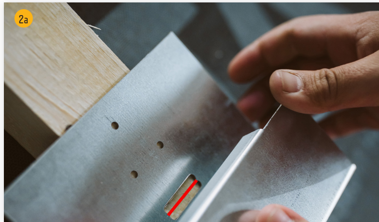
2a Am Schnurschlag ausrichten oder ....
